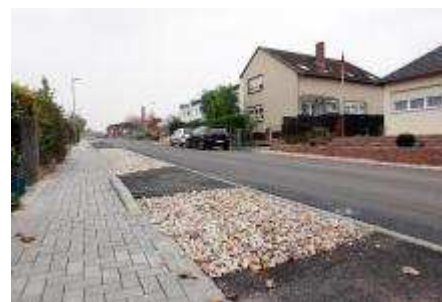
Mit Schotter gefüllte Mulden sollen für die bessere Entwässerung in der höher gelegten Ober-Olmer Straße zwischen US-Kaserne und L 419 sorgen. Foto: hbz/Judith Wallerius
